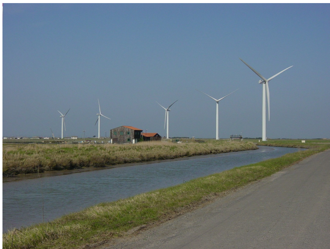
Parc éolien de Bouin (85) © EDF En
