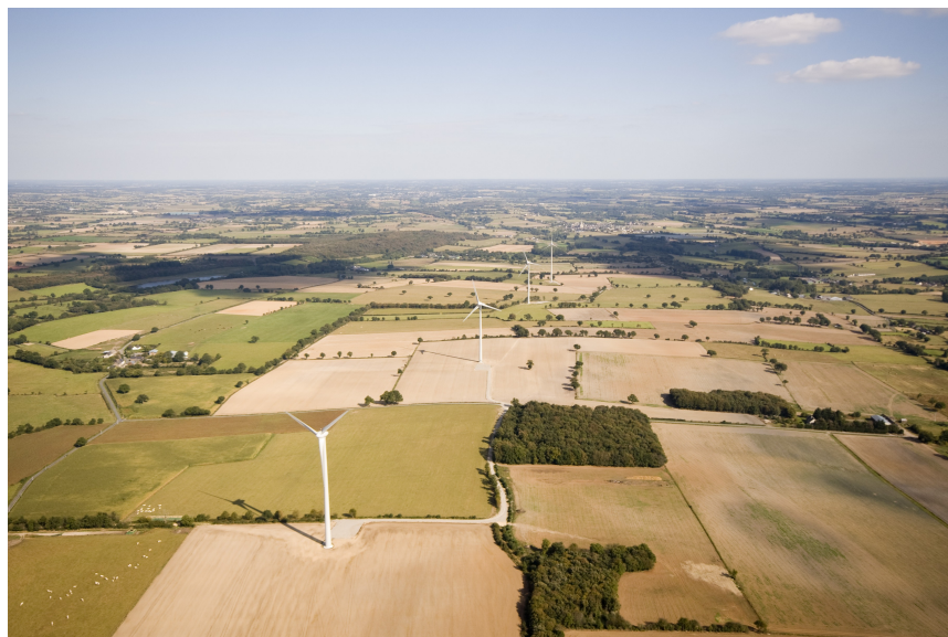
Parc éolien de Freigné(49) © Energie Team
