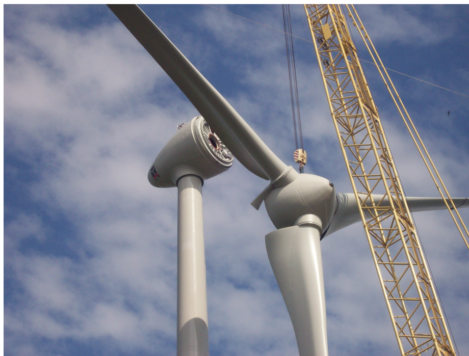
Mise en place de l'éolienne de Freigné (49) © Energie Team
