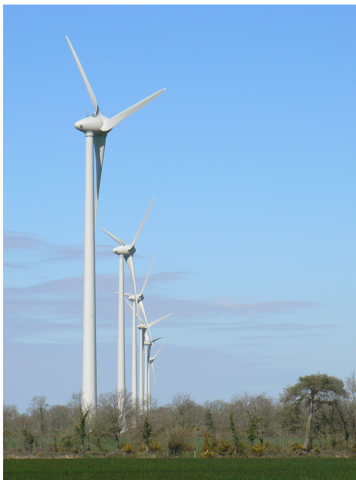
Parc éolien de Beaufou (85) © Energie Team
